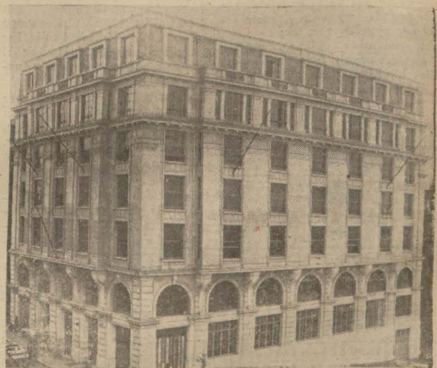
Elektrik, Tramvay, Tünel İdaresi binası
