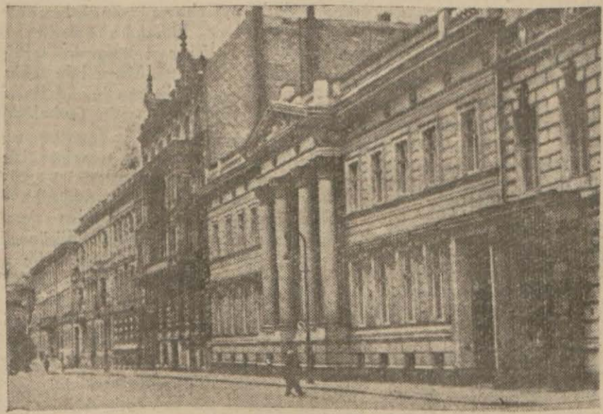
Berlinde hasara uğrayan haricije nezareti binası
